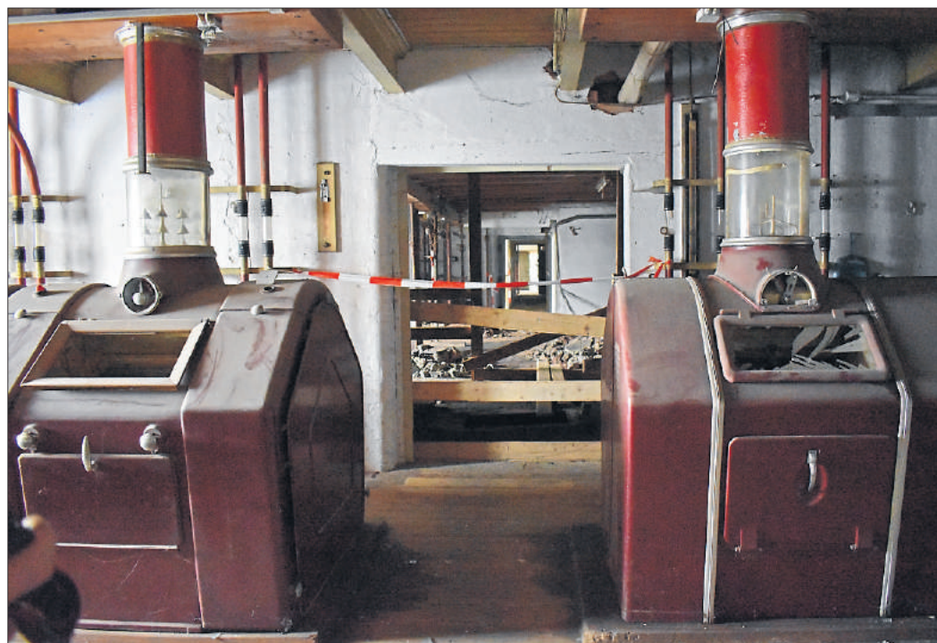
Die Räume der alten Heyl-Mühle sind wie ein Labyrinth und teilweise wegen Einsturzgefahr gesperrt. Für die alten Maschinen gibt es keine Verwendung mehr. Fotos: Leoni Rehnert
