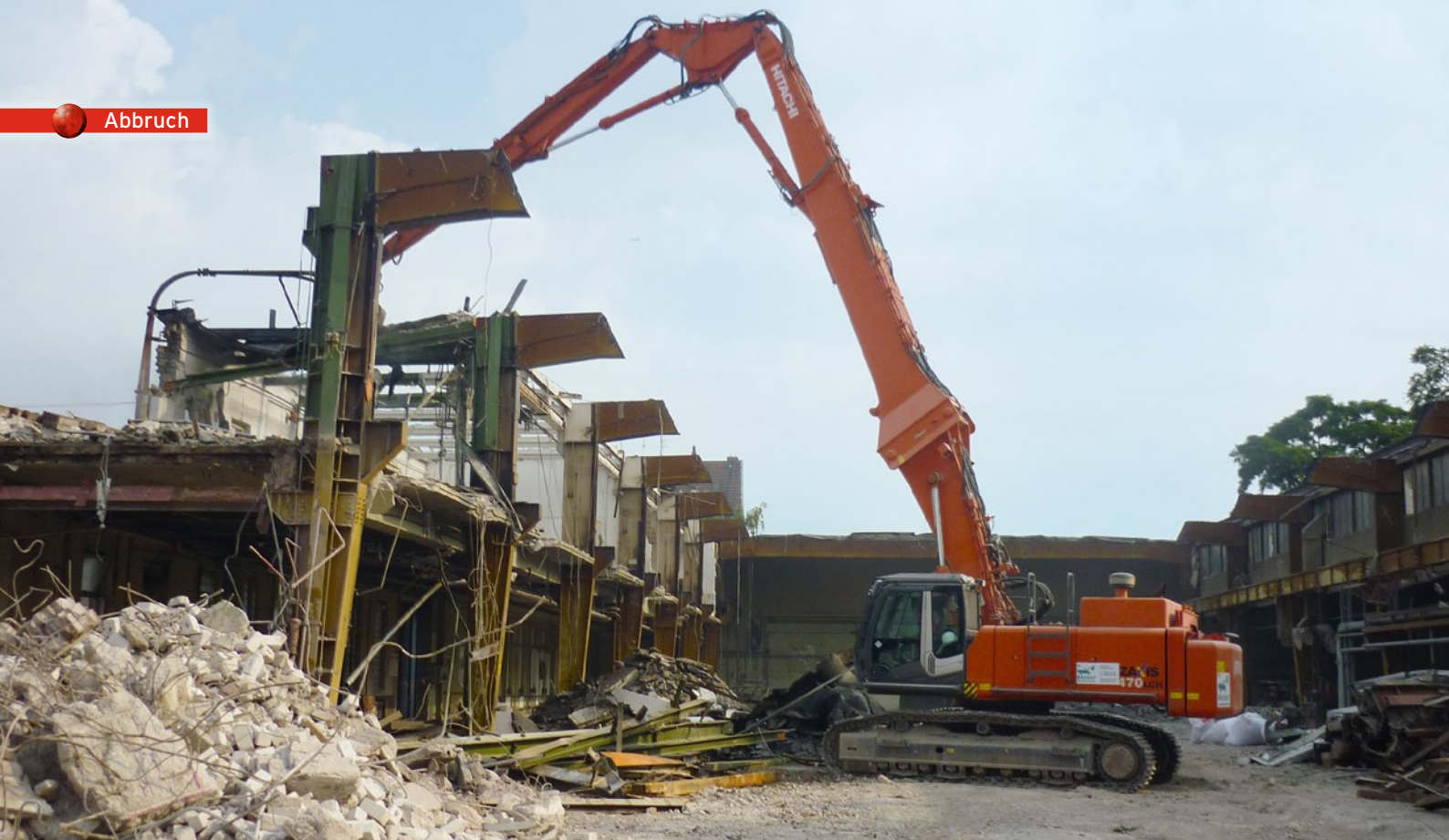
Die Hallen der ehemaligen Clouth-Werke werden derzeit abgerissen
